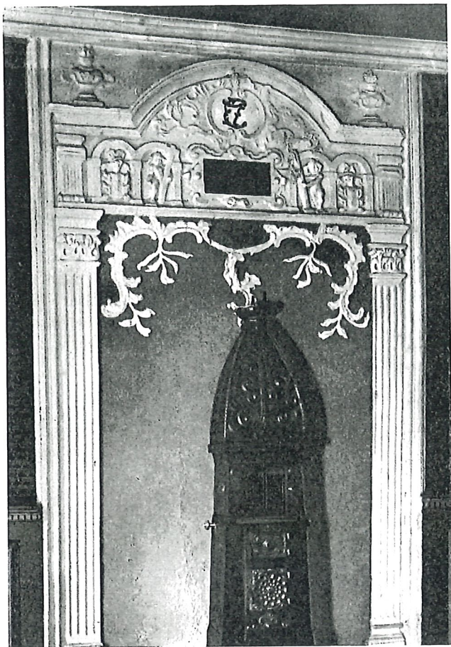
Kakkelovnspladsen i den blaa Stue.
